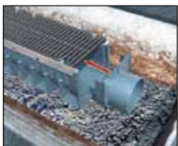
Герметизация соединений
