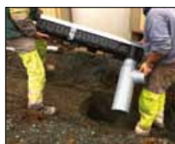
Установка песколовки
