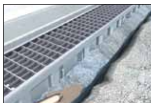
Бетонирование и укладка покрытия
